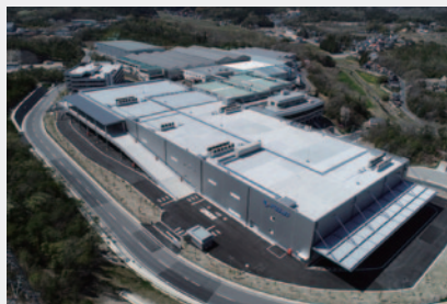
豊田事業所 新生産棟
