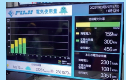
使用電力状況ダッシュボード
