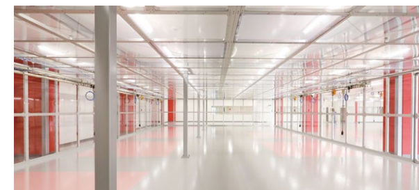
スーパークリーンルーム
